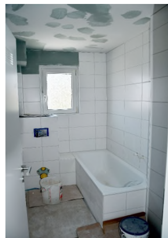
Wohnung im Medebekskamp 2a während der Modernisierung
