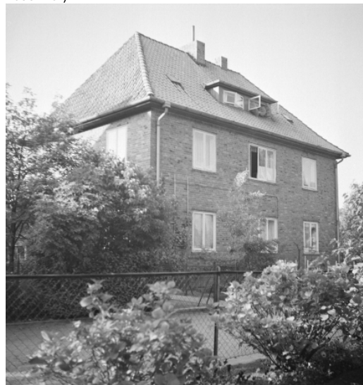
Bellmannskamp 7, gebaut 1929; um 1950 (Stadtarchiv Lüneburg – Hildegard Garbade)
