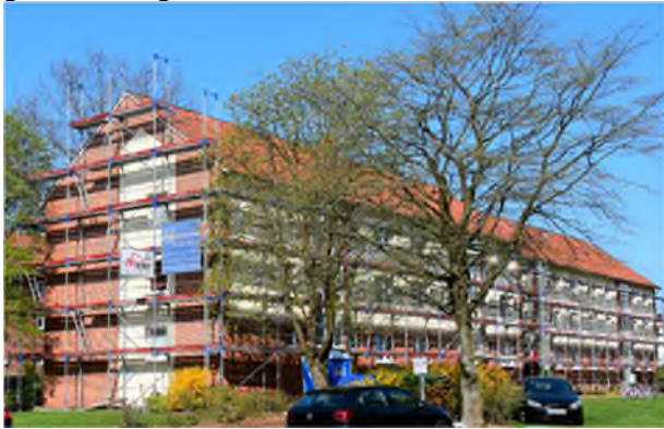
Yorckstraße 26-32 während der Bauphase 2018
