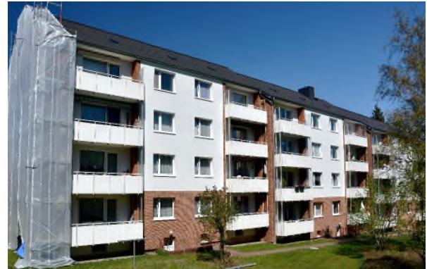
Bennigsenstraße 13-17 im Frühjahr 2019 kurz vor dem Abschluss der Maßnahmen
