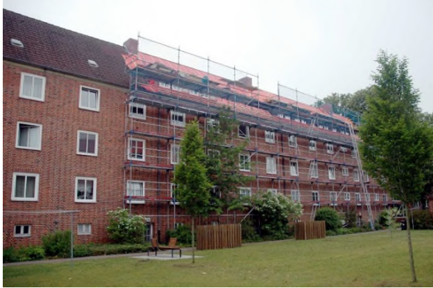
Kefersteinstraße 21-29 (Hofseite während der Dacherneuerung im Mai 2016)
